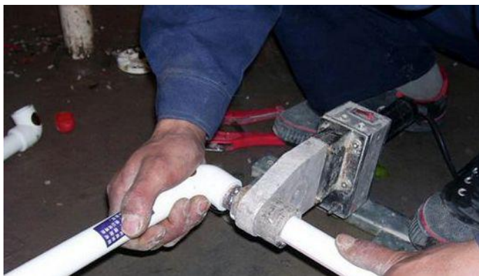
7. 不同材质的管线，不能简单使用热熔的方式连接。
