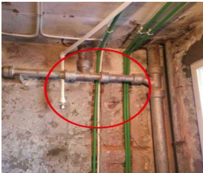
7. 不同材质的管线，不能简单使用热熔的方式连接。
